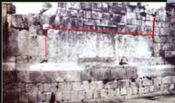
Des blocs de pierre géants furent utilisés dans la construction de cet édifice, aujourd'hui baptisé Temple de Jupiter. Le bloc marqué de rouge sur la petite photographie est l'un des trois monolithes d'appui, mesurant chacun 3,5 mètres de haut, 3,5 mètres de large et 19 mètres de long et pesant en moyenne 800 tonnes. Le fait que de si gros blocs de pierre purent être extraits et transportés depuis les carrières suggère qu'un matériel avancé a dû être employé.
