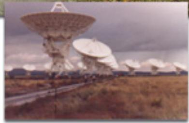
Chacune de ces antennes pèse 212 tonnes, mesure 25 mètres de diamètre et est de la taille d'un bâtiment de dix étages.<sup>215</sup>
