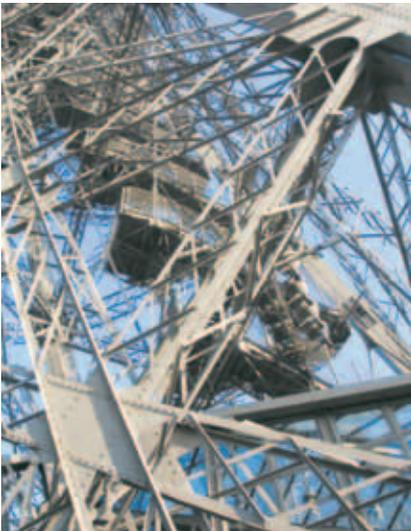
**La Tour Eiffel fut construite avec une structure similaire à celle de l'extrémité du fémur. Grâce à cet agencement, la tour possède une structure inébranlable qui résout également les problèmes de ventilation.**
